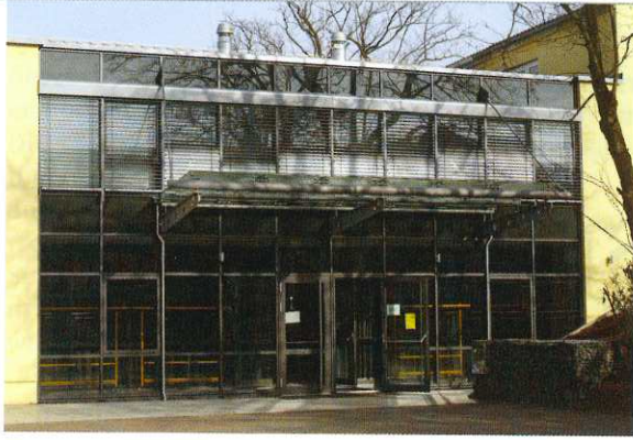
In der Georg-Büchner-Schule sorgt eine zeitgemäße Gebäudeautomation mit KNX für optimale Beleuchtung und Temperatur
