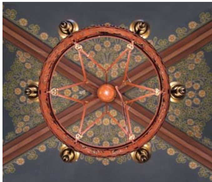
Der im Leuchter installierte und lackierte Melder ist als solcher kaum erkennbar
